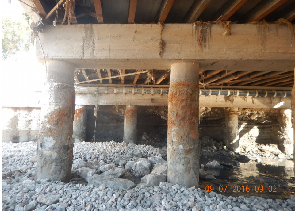
Fotoğraf 50. Meles Deresi Taban Islahı Taş Dolgu Çalışması
