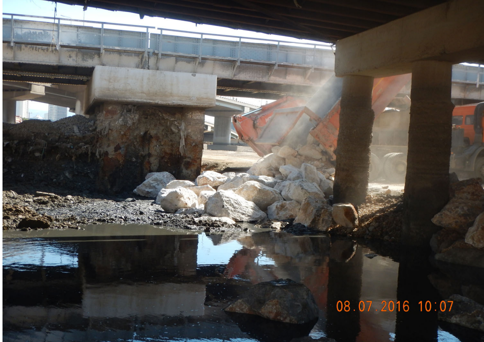
Fotoğraf 49. Meles Deresi Taban Islahı Taş Dolgu Çalışması
