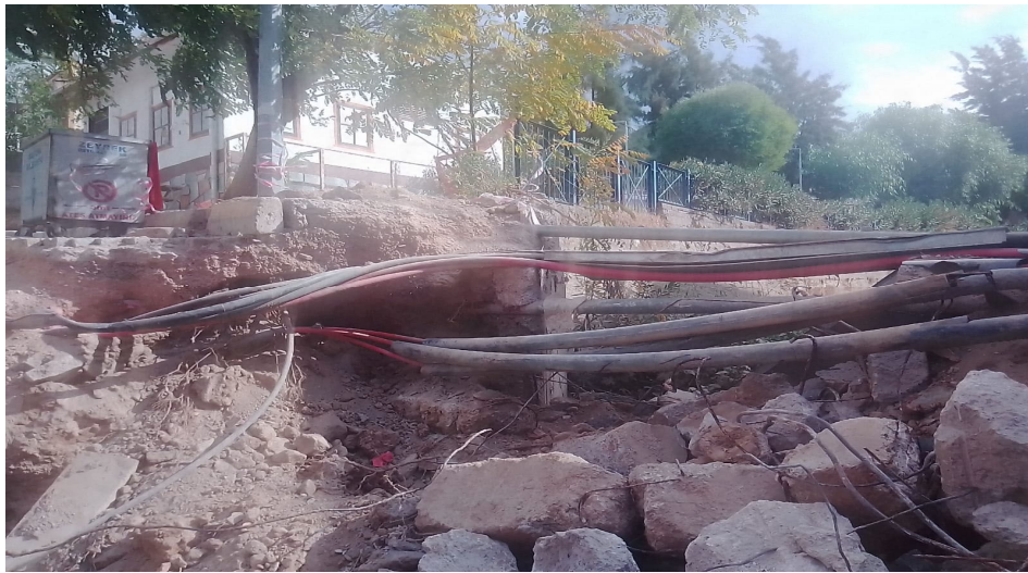
Fotoğraf 9. Hacı Ahmet Deresi Kontrolsüz Alt Yapı Bağlantıları
