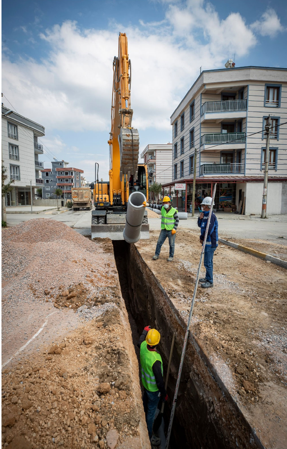
Fotoğraf 79. Kanalizasyon, Yağmur Suyu Hattı
