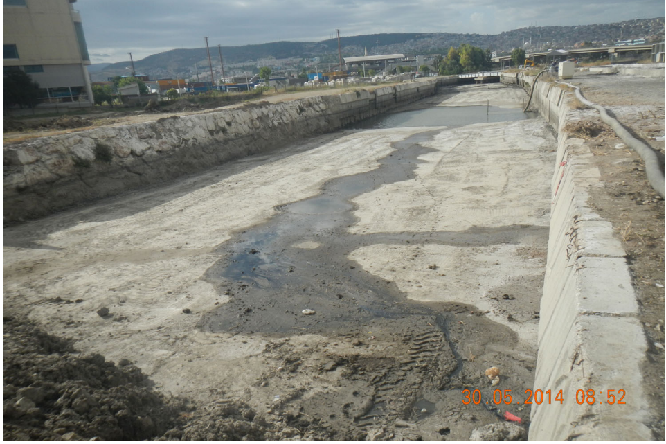
Fotoğraf 54. Arap Deresi Islah Çalışmaları Tamamlanan Kısımlar
