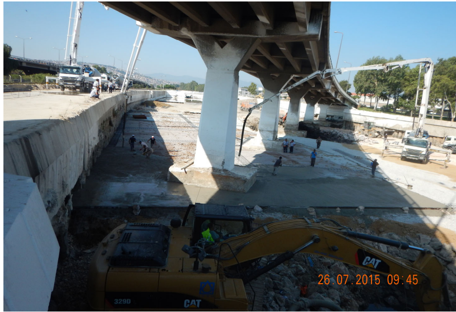
Fotoğraf 47. Meles Deresi Taban Kısmı Parça Beton Tamiratları
