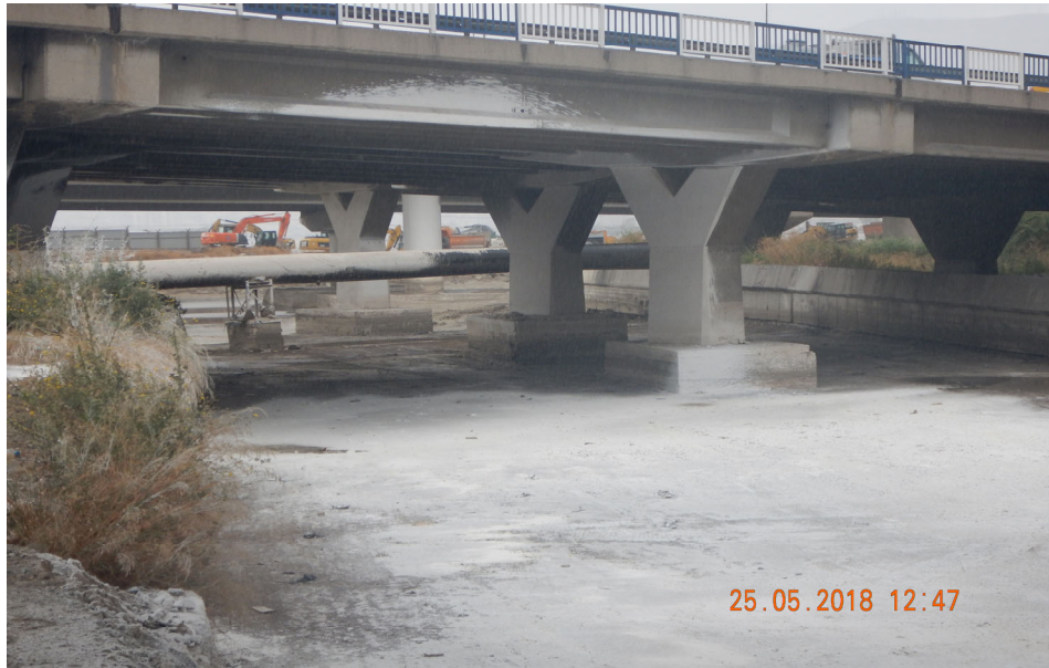
Fotoğraf 55. Arap Deresi Islah Çalışmaları Tamamlanan Kısımlar
