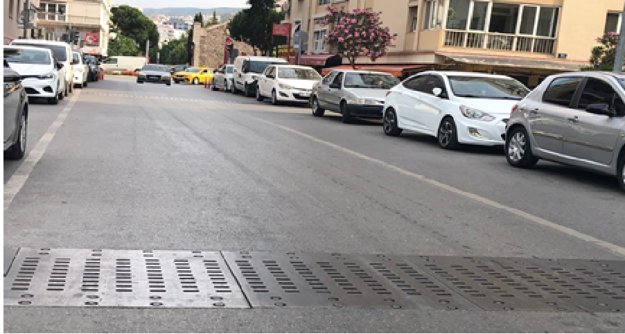
Fotoğraf 78. Sıralı Yağmur Suyu Hattı
