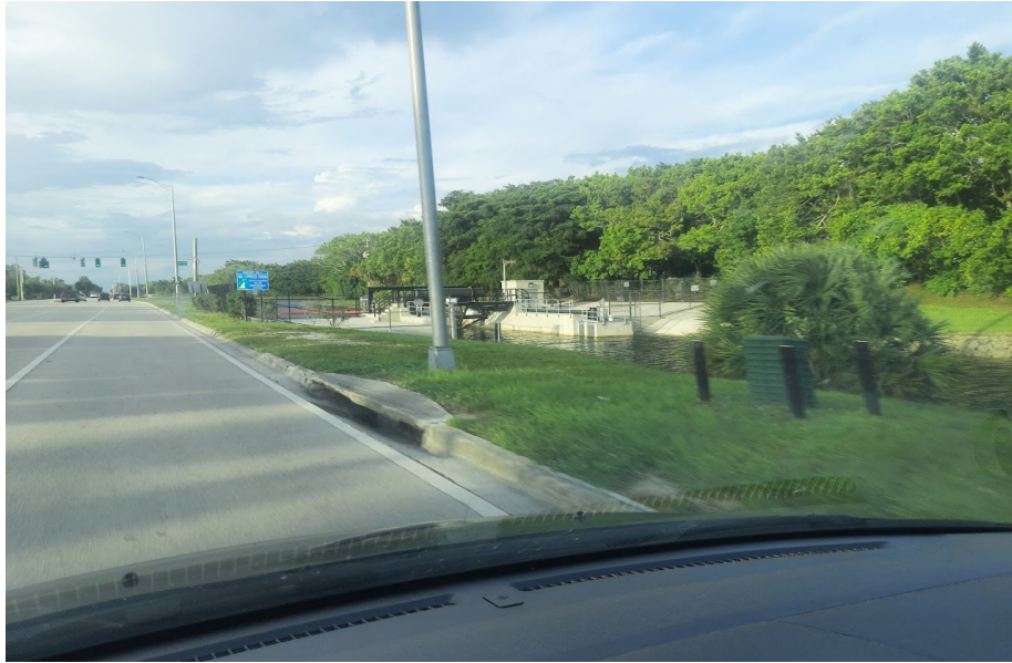
Fotoğraf 67. Naples, Florida Dere Yatağı Sürüntü Malzeme Temizlik ve Akış Düzenleme Amaçlı Terfi Merkezi
