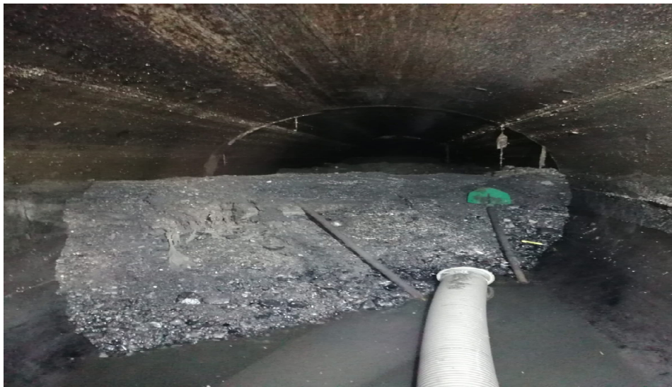
Fotoğraf 84. Kolektör Hattı Temizlik ve Görüntüleme Çalışması
