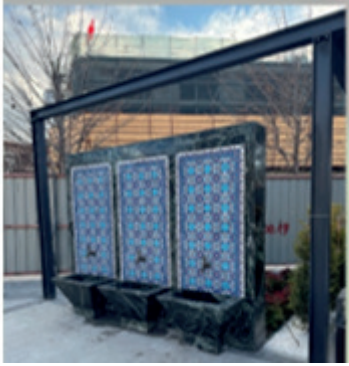
Çeşmelerin ön cephesi
