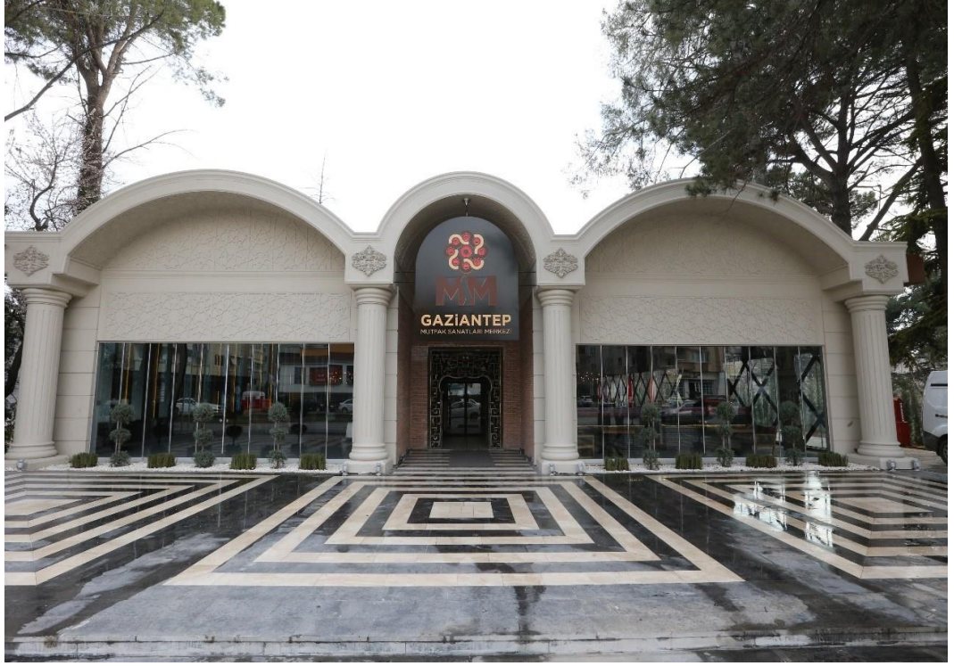
Şekil 13 Gaziantep Mutfak Sanatları Merkezi
