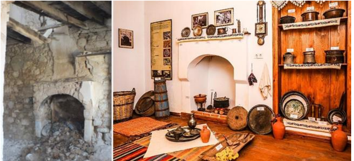
Görsel 24. 1946 Parsel (yeni 4428 ada 9 parsel)- Zemin Kat Güneybatı Yönde Konumlanan Oda
