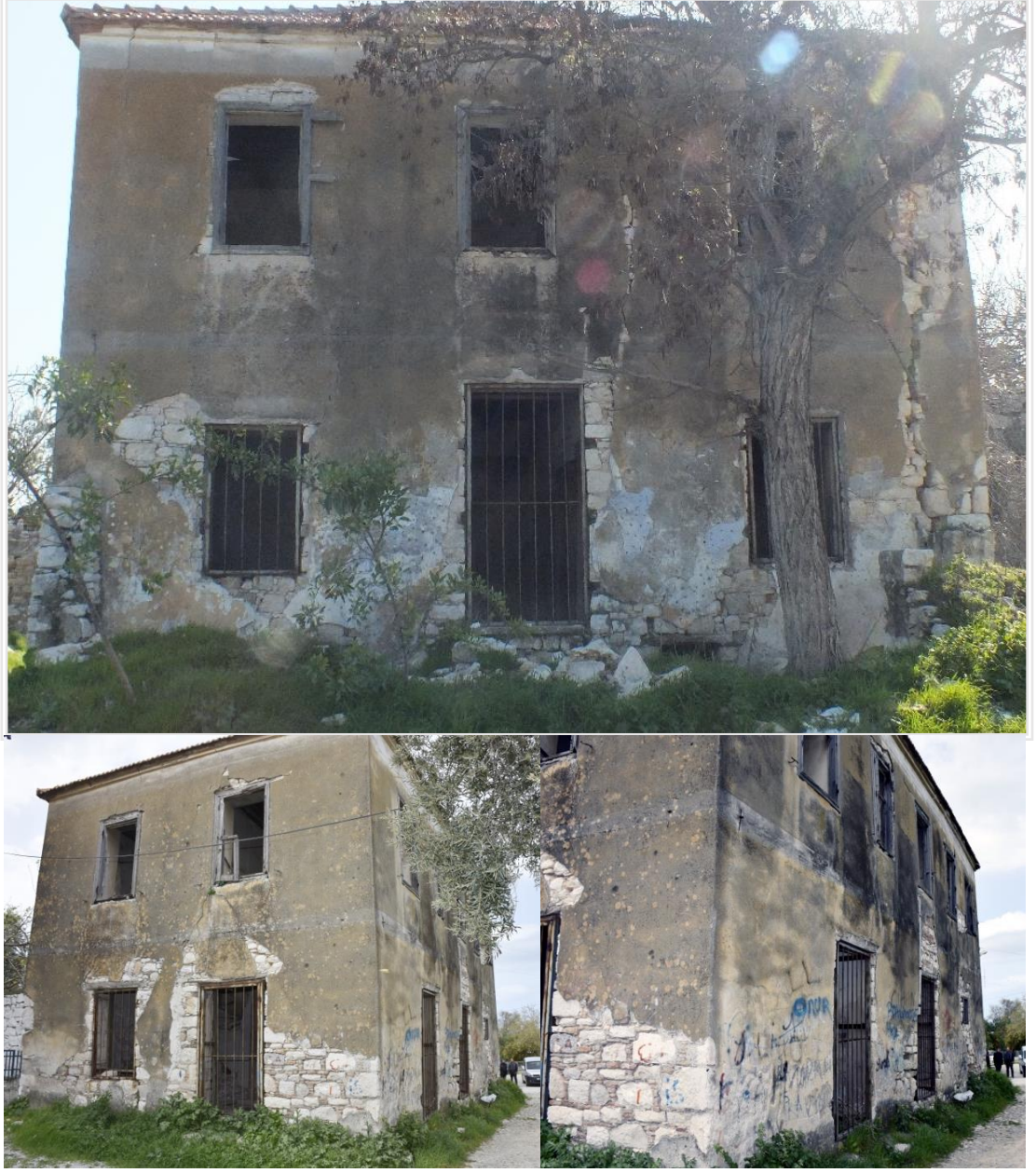
Görsel 23. 1946 Parsel (yeni 4428 ada 9 parsel)- Restorasyon Öncesi ve Sonrası
