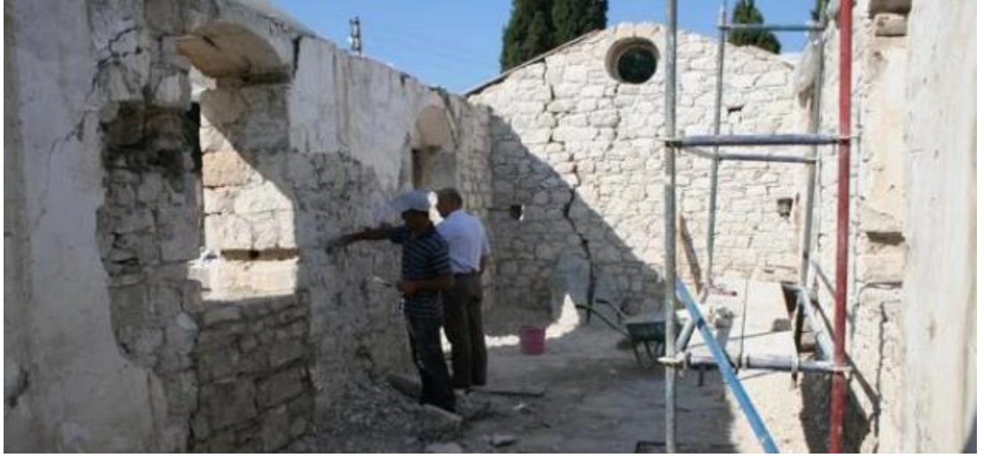
Görsel 29. 1878 Parsel (yeni 4418 ada 1 parsel) – Restorasyon Çalışması
