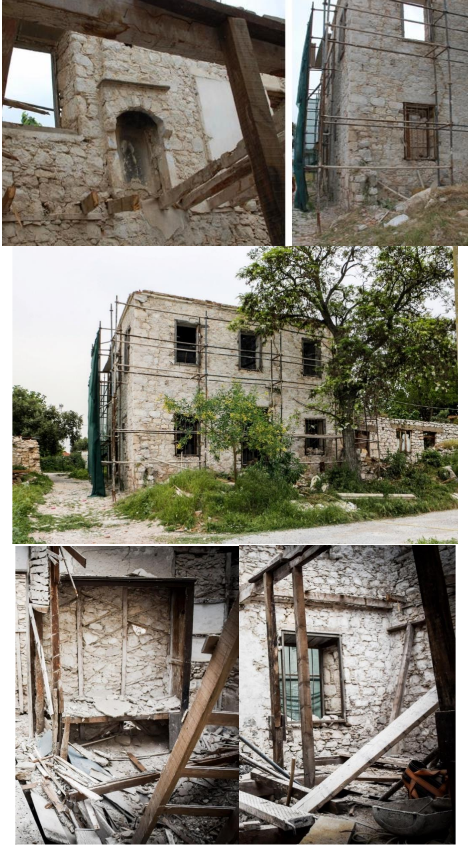
Görsel 25. 1946 Parsel (yeni 4428 ada 9 parsel)- Restorasyon Çalışması
