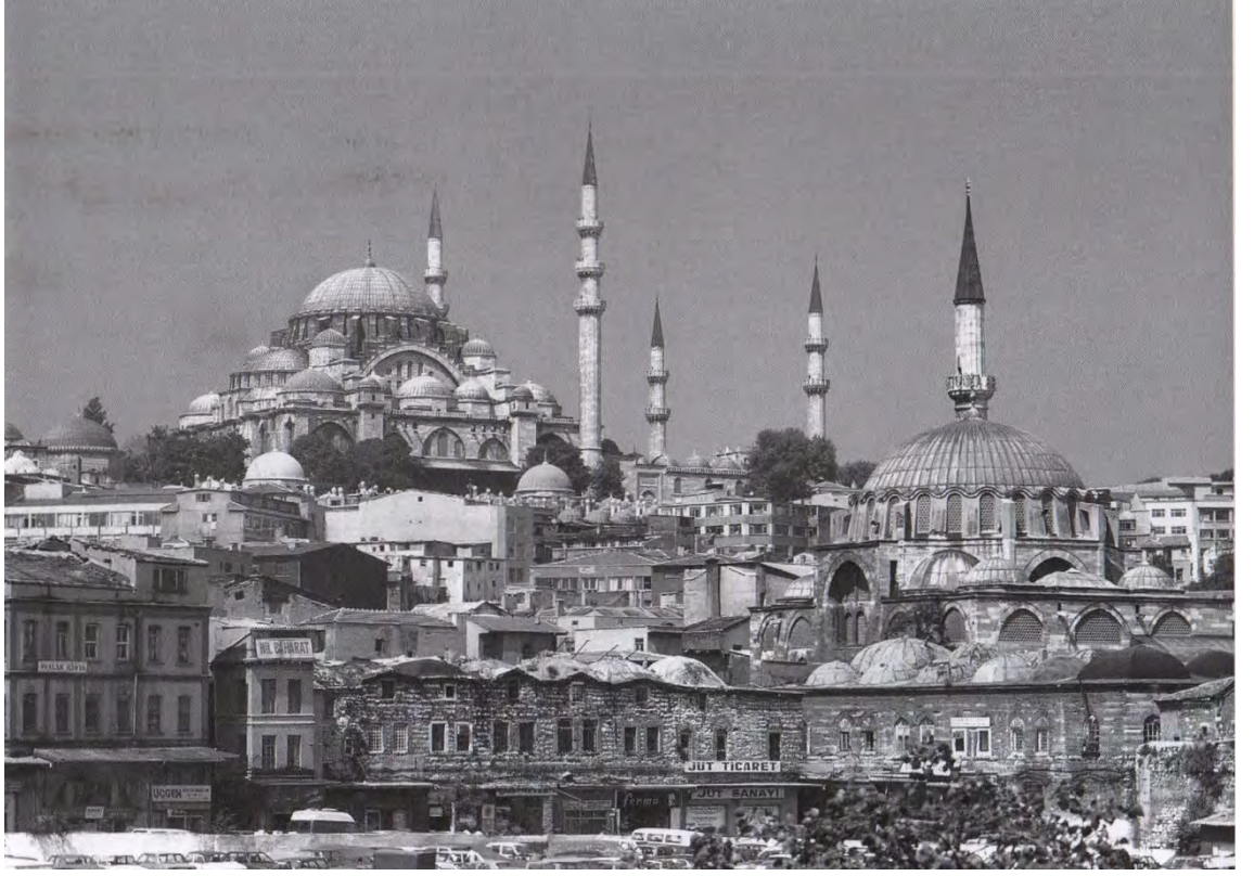
Fotoğraf 85. Rüstem Paşa Camii'nin Süleymaniye Camii ile İstanbul Silüetinde Görünümü
