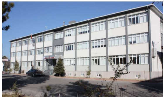
Niğde İl Özel İdaresi Hizmet Binası
