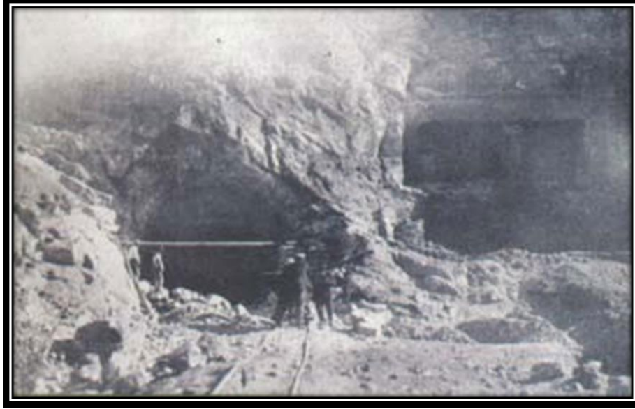
Şekil 41. 1926 Yılında Amasya’da Devlet Demir Yolları İnşaatı (Menç, 2007: 174).
