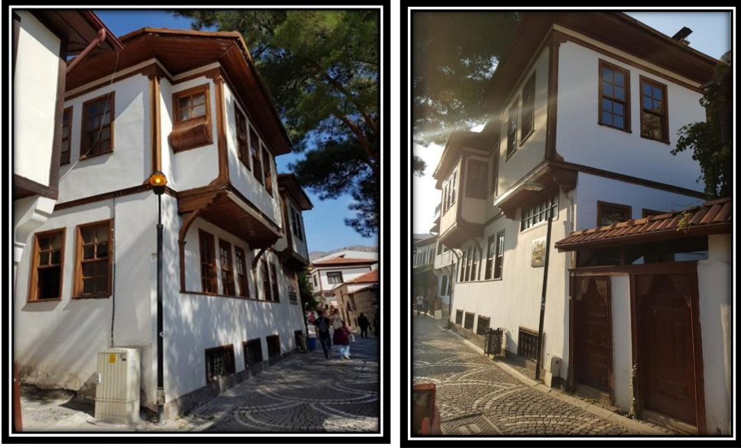
Şekil 9. Tarihi Kent Dokusunu Koruyarak Yeni Yapılaşma Cumbalı İsmet Çopuroğlu Konağı (Ladikli, 2022).
