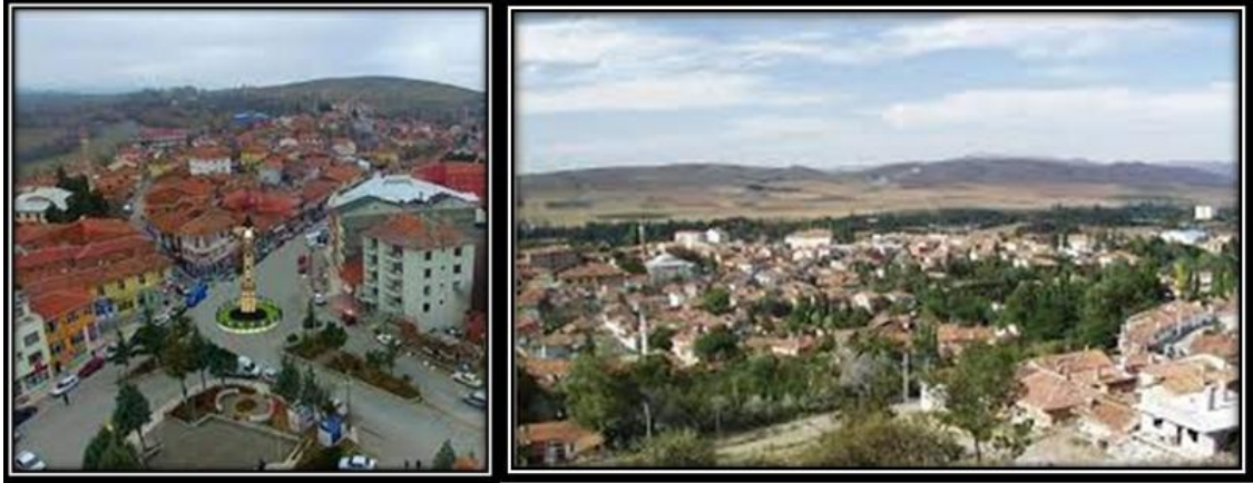
Şekil 30. Mecitözü Meydanı ve Genel Görünüm (Mecitözü Belediyesi, 2022), (Çorum İl Kültür ve Turizm Müdürlüğü, 2022)
