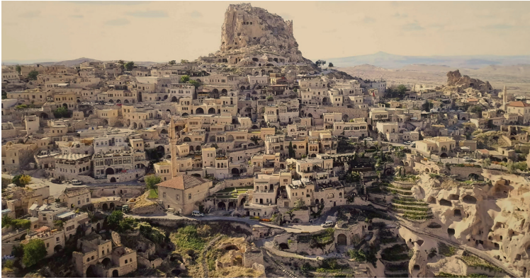
Resim 37: Argos in Cappadocia oteli vesilesiyle dönüşerek yeniden yaşama katılan Uçhisar'ın Aşağı Mahallesi, yeniden yapılandırılan mimari birimlerin birbiriyle ve doğal zeminle uyum içinde kalmaya özen gösterildiği bir koruma projesidir.
