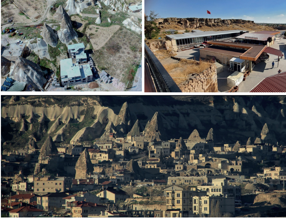
Resim 10, 11, 12: Kapadokya'nın korunması önündeki en büyük tehdit, doyumsuz “yeni yapılaşma hırısı”. Resim 10/12: Galip Hasan Temur
