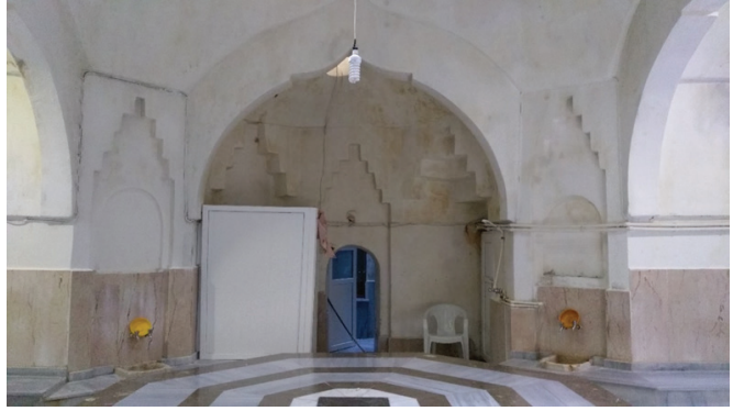
Fotoğraf 11 – 12. Amasya Kumacık Hamamı traşlık ve sıcaklık girişindeki eyvanın kemer ve nişleri
