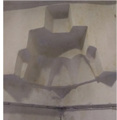
Fotoğraf 15 – 16. Amasya Kumacık Hamamı sıcaklık bölümü kuzeydoğu eyvanı ve kubbeye geçiş trompu
