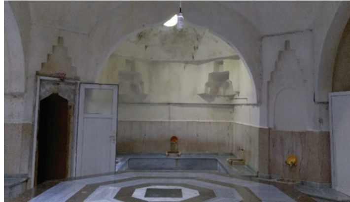
Fotoğraf 15 – 16. Amasya Kumacık Hamamı sıcaklık bölümü kuzeydoğu eyvanı ve kubbeye geçiş trompu
