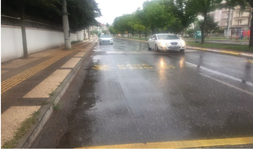
Şekil 19. Aksaray Nakkaş Mahallesi Yol Üzeri Beton Kasis Uygulaması
