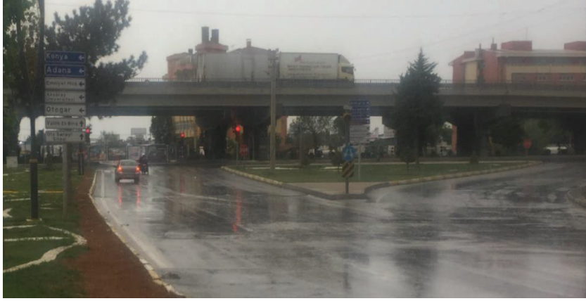
Şekil 6. Aksaray E-90 Sanayi Alt Geçidi
