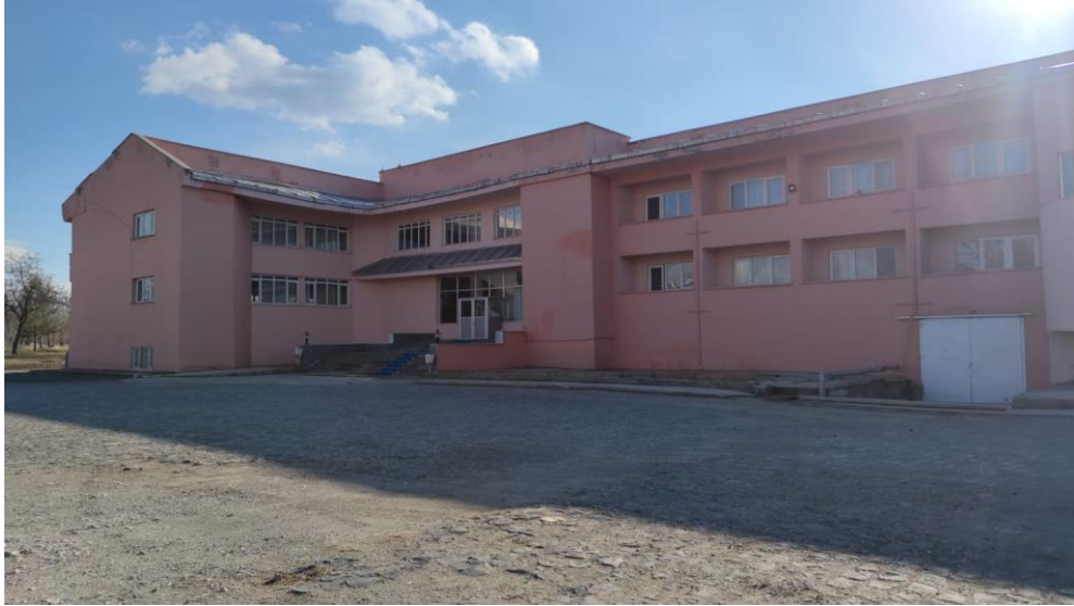
Şekil 24. Ağrı Şeker Fabrikası Misafirhanesi
