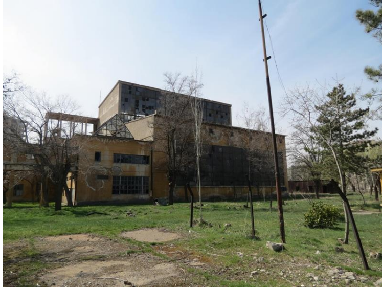
Şekil 94. Enerji Santrali Görünümü
