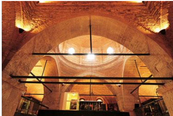
Şekil 38. Lengerhane Restorasyon Sonrası Görünümü
