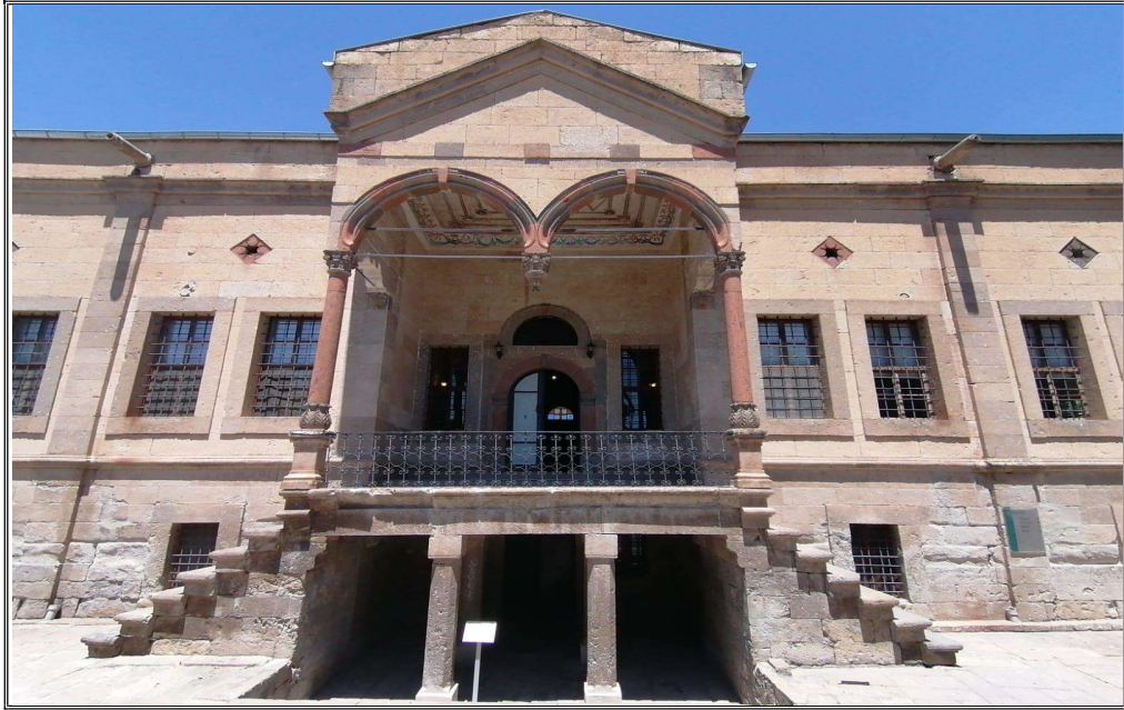
Resim 15. Kapadokya Üniversitesi Rektörlük Binası
