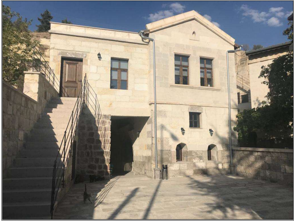
Resim 16. Kapadokya Üniversitesi Enstitü Binası Önden Görüntü.
