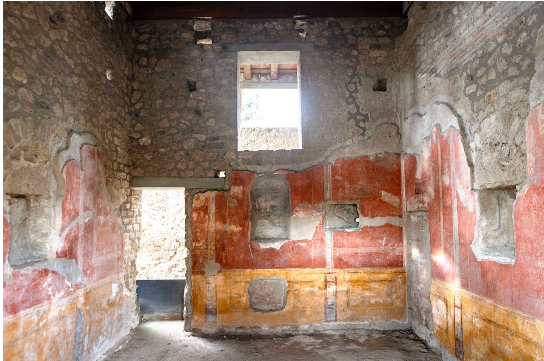
Şekil 15. Yürüyüş yolu boyunca triclinium un iki yanındaki odalardan biri. Yürüyüş yolu cephesinden çekilen bu fotoğrafta solda odanın koridor (c) üzerindeki giriş kapısı. Kapının sağında, ortada bir niş onun sağında koridordaki serin havayı içeri aktaran prizma formundaki oyuk. (Fotoğraf: G. Göksoy)
