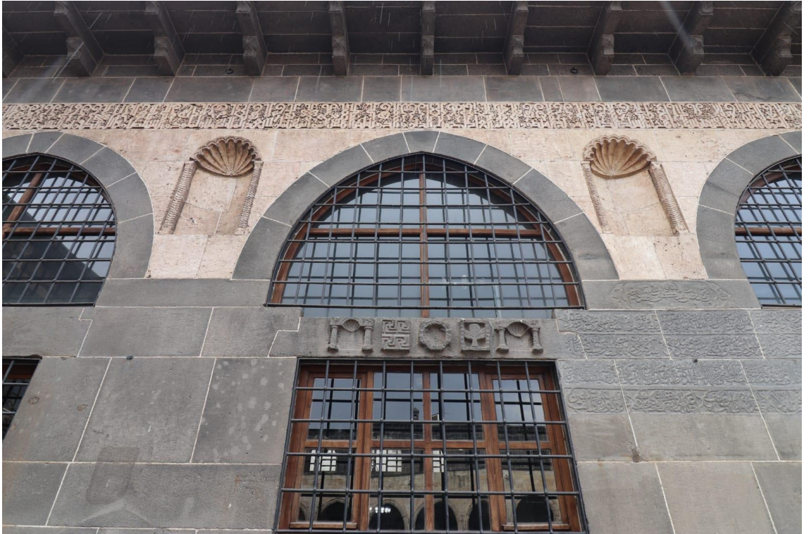
Fotoğraf 44: Hanefiler Camii Dış Cephe (Nazlı Turan Arşivinden)
