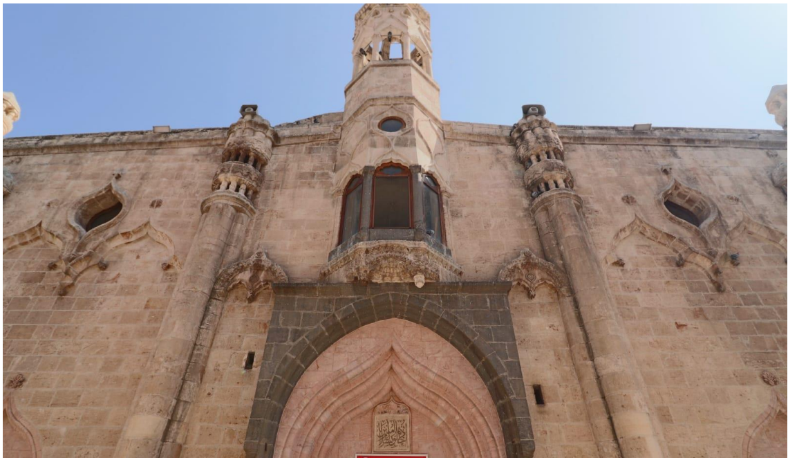
Fotoğraf 5: Firfirli Camii Batı Cephesi (Nazlı Turan Arşivinden)
