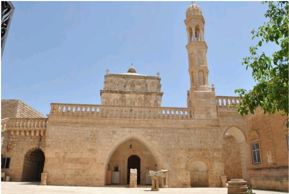
Fotoğraf 23: Meryem Ana Kilisesi Batı Cephesi (Turan, 2019)
