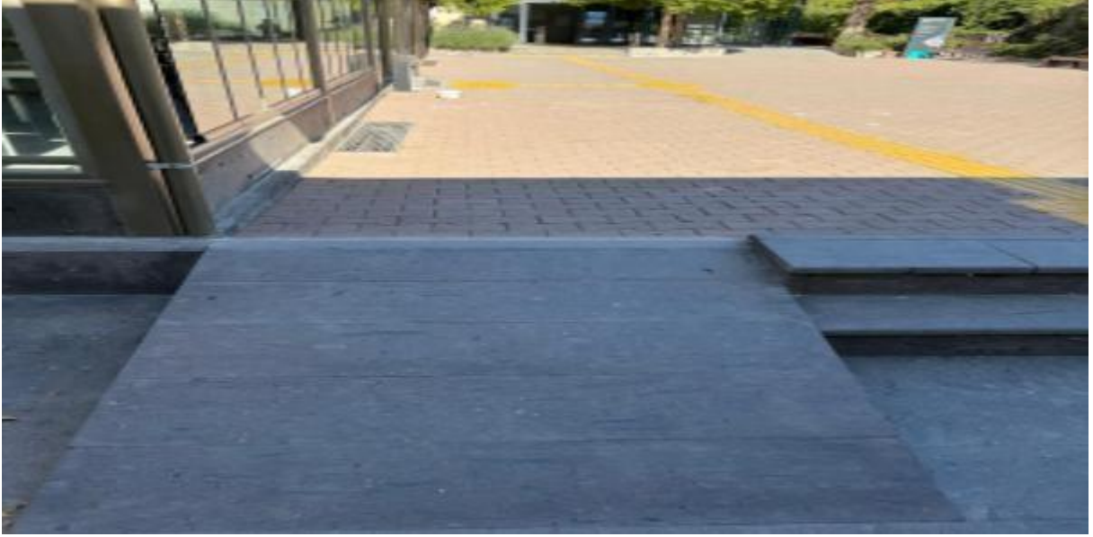
Kanıt 7.5.8: Oktay Sinanoğlu binasında yürüme veya bedensel engelli öğrenciler için tasarlanmış rampa düzeneği.
