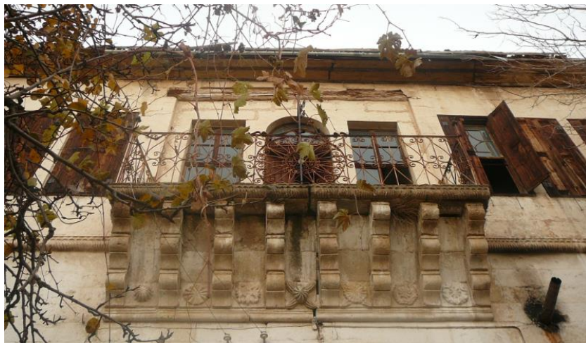
Resim 96: Balkon Altı Konsol Detayı
