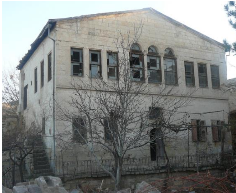
Resim 118: Yapının Ön ve Yan Cephesi
