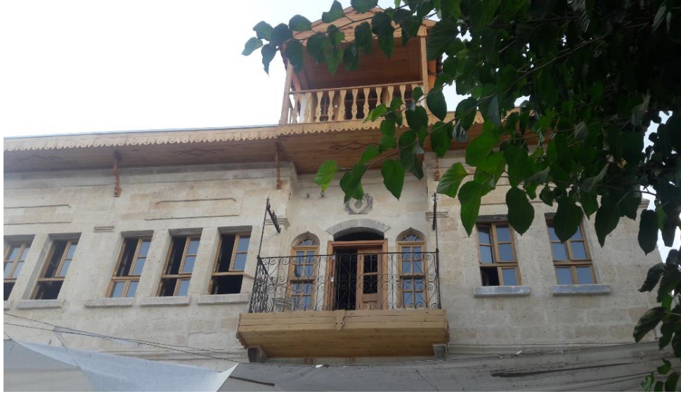
Resim 249: Yapının Birinci Kat ve Çatı Katı Cephesi
