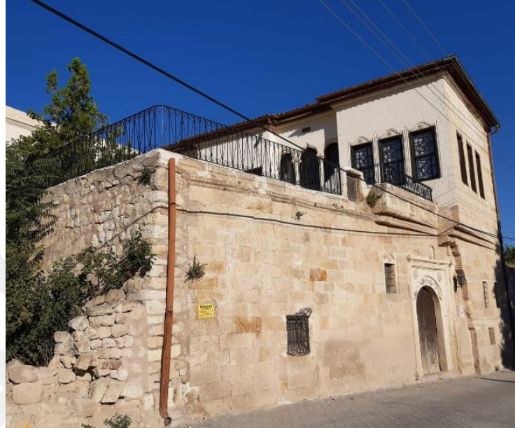
Resim 221: Yapının Karağandere Sokak Üzerinden Görünümü
