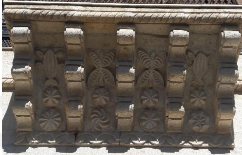
Resim 205: Balkon Altı Konsol Detayı
