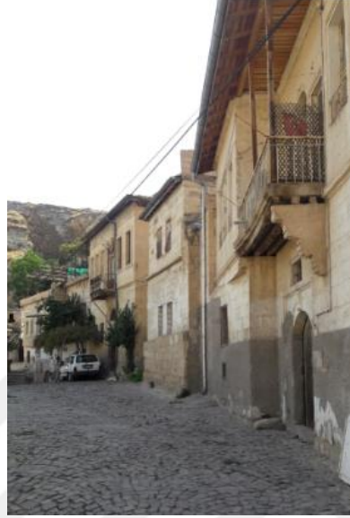
Resim 58: Avlusuz Konut Örnekleri, Dereler Mahallesi, Ürgüp
