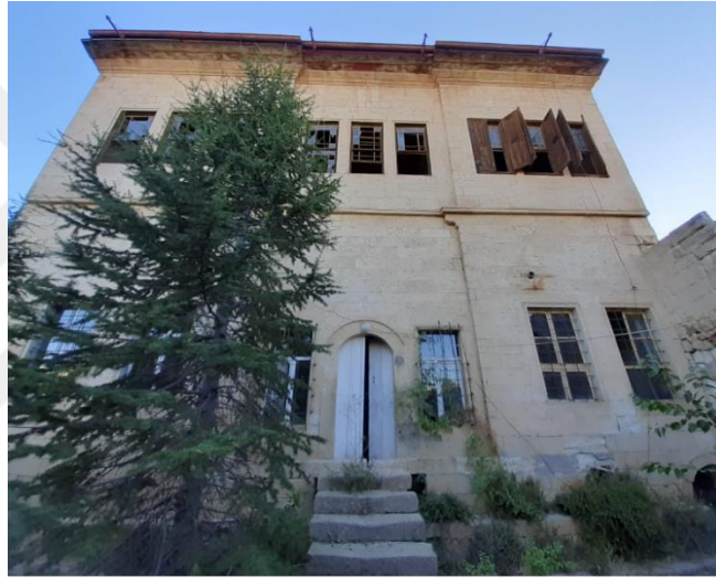
Resim 194: Yapının Ön Cephesi
