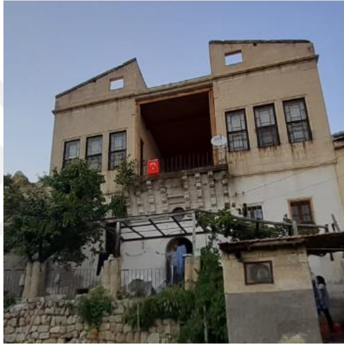
Resim 260: Yapının Ön Cephesi
