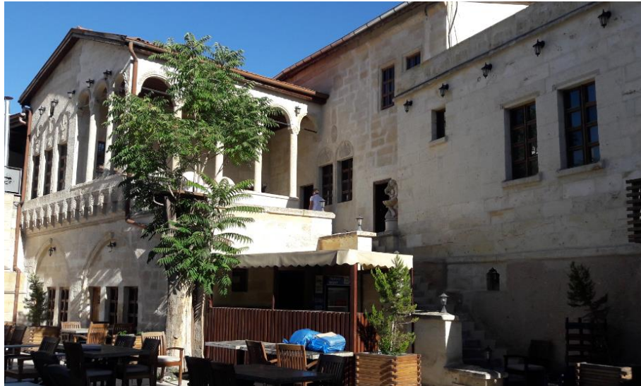
Resim 178: Yapının genel görünümü
