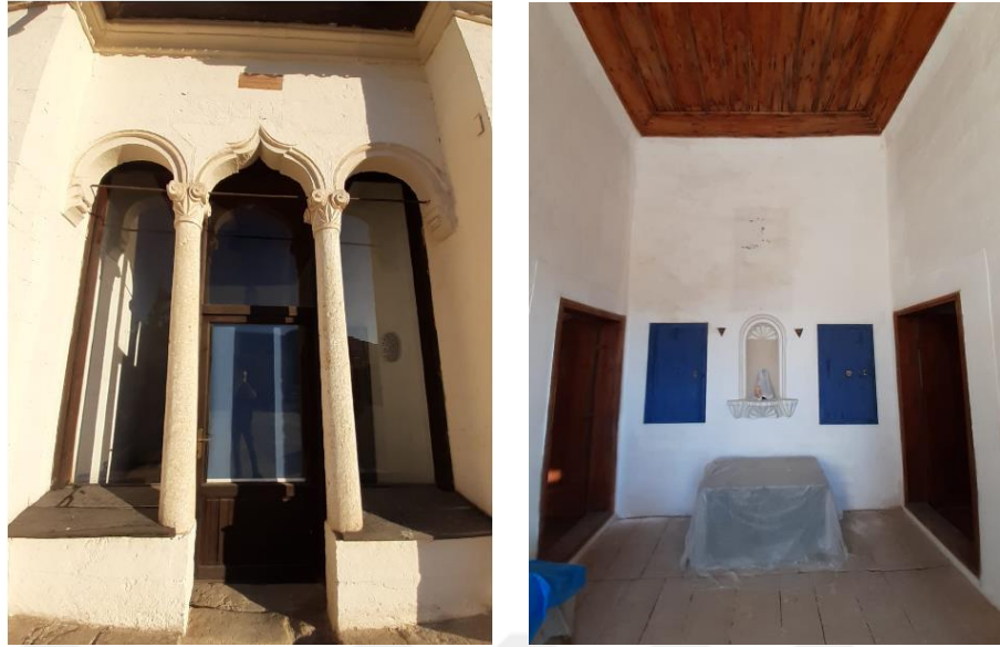
Resim 220: 3.Divanhanenin Dış Mekan ve İç Mekan Görünüşü
