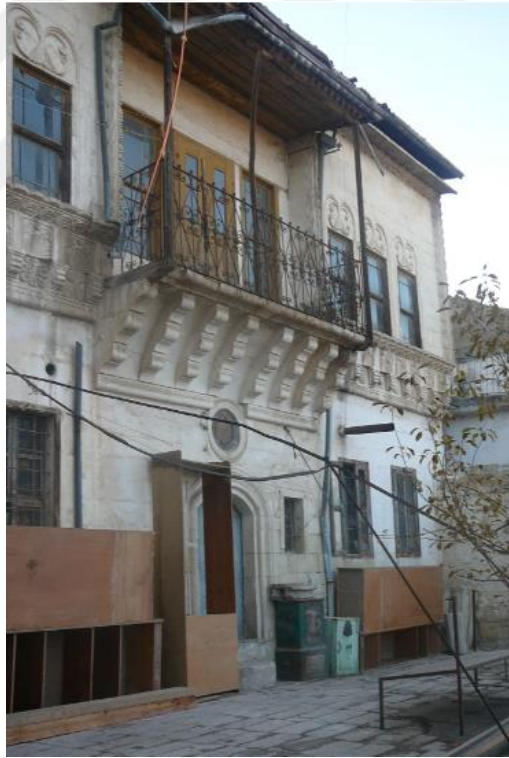
Resim 124: Yapının Ön Cephesi
