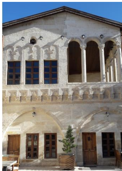
Resim 182: Yapının Ön Cephesi
