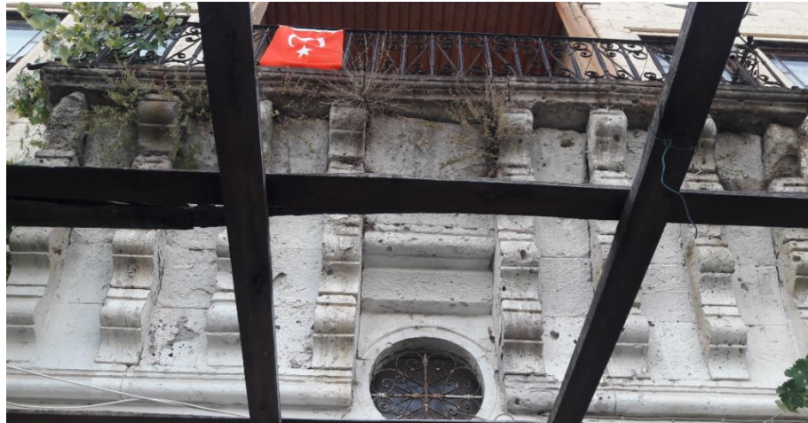
Resim 261: Yapının Balkon Altı Konsolu
