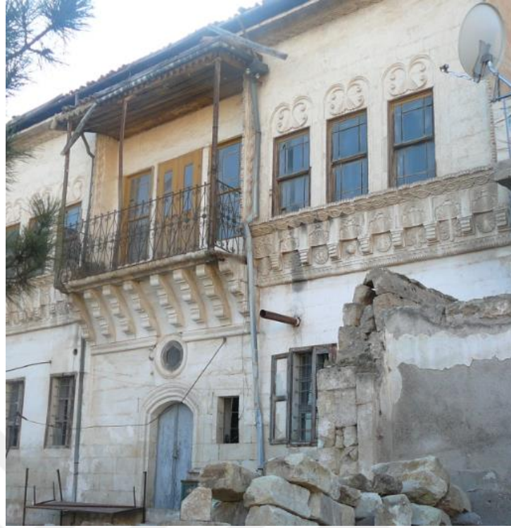
Resim 127: Yapının Ön Cephesinde Yer Alan Taş Bezeme
