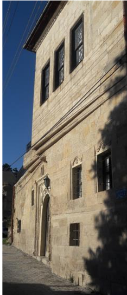
Resim 227: Cephede Yer Alan Gönyeli Kat Silmesi
