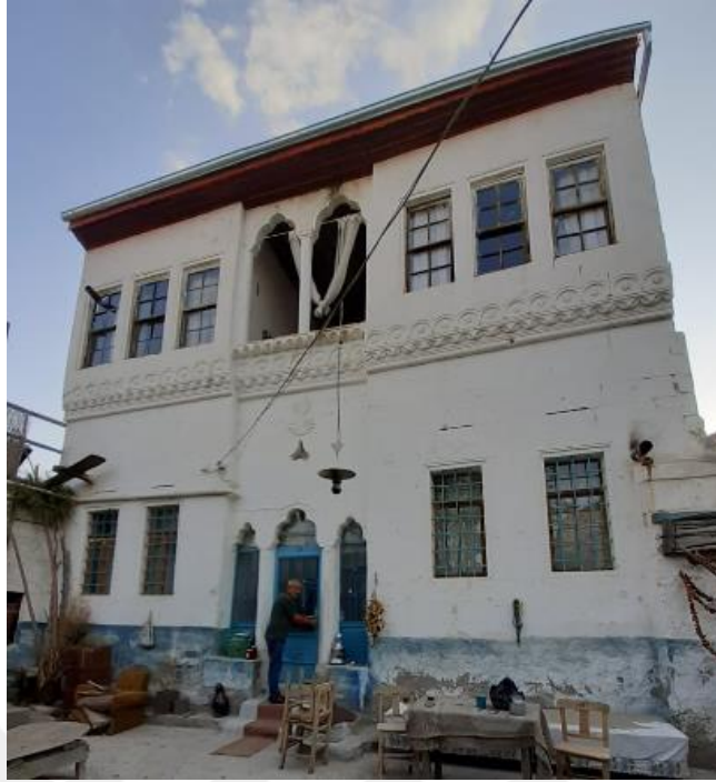
Resim 270: Yapının Ön Cephesi
