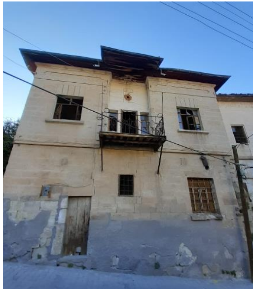
Resim 102: Yapının Barbaros Hayrettin Sokağı Bakan Ön Cephesi
