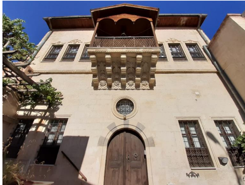
Resim 203: 12 Numaralı Ev Ön Cephe
