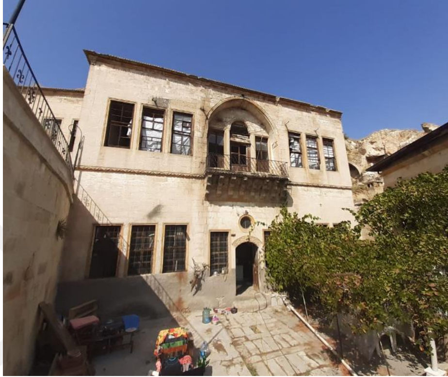
Resim 280: Yapının Ön Cephesi
