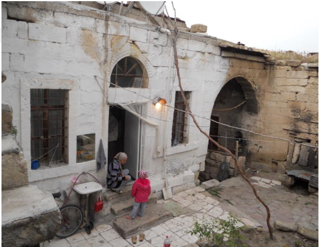
Resim 129: 5 Numaralı Ev Ön Görünüş
