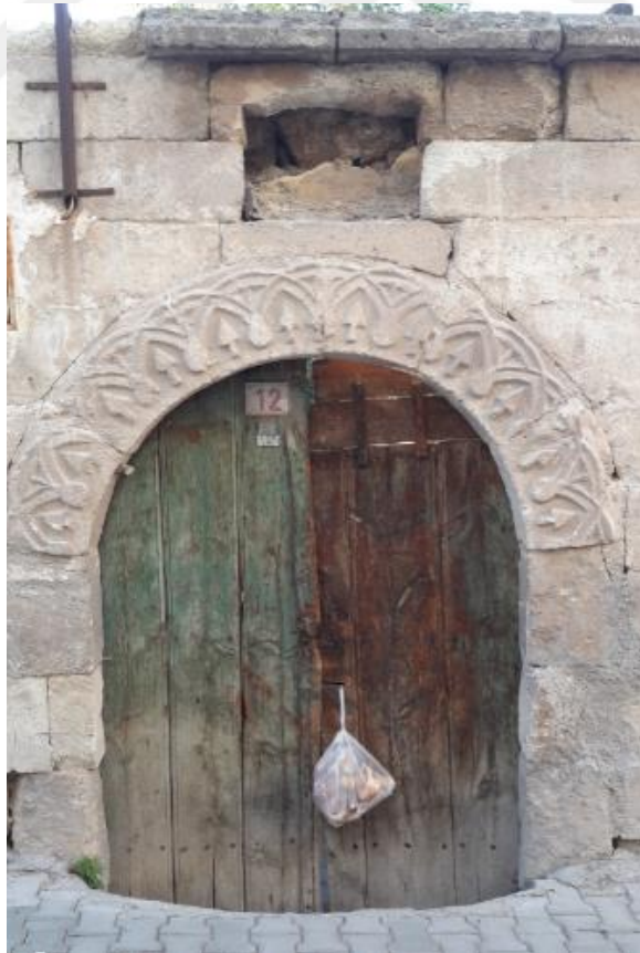
Resim 130: 5 Numaralı Evin Avlu Kapısı
