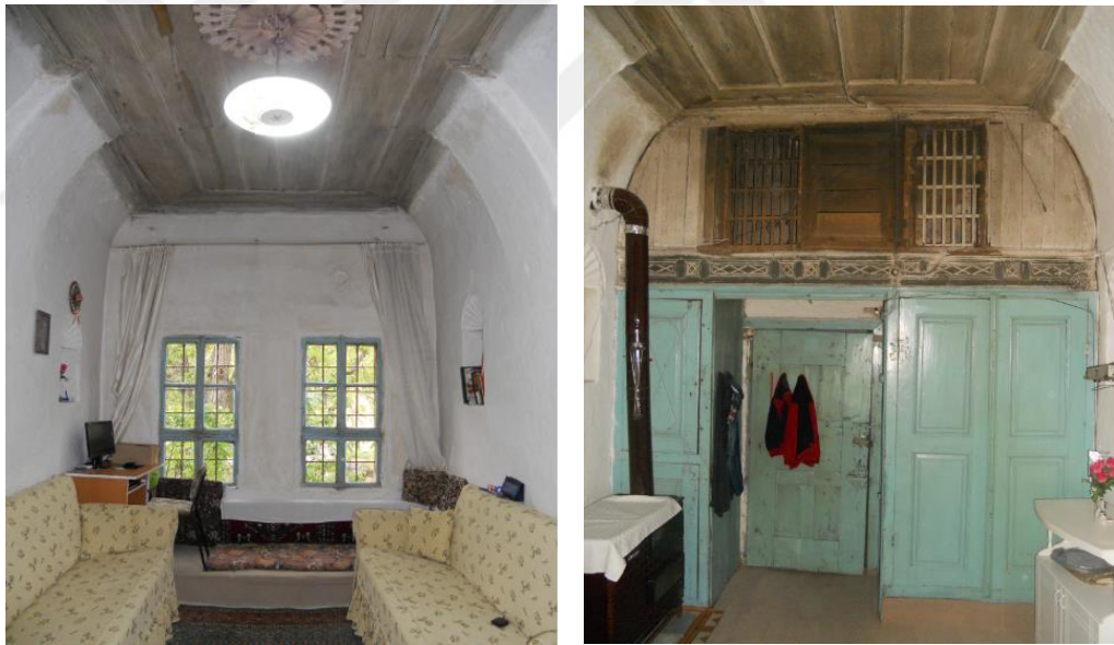
Resim 131: Z-03 Numaralı Odanın Pasalı Ahşap Tavanı ve Dolap Detayı
