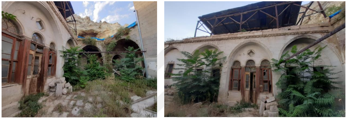
Resim 254: Konağın Arkasında Yer Alan Mekanlar
