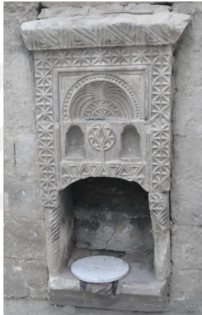
Resim 161: Üst Örtüsü Günümüzde Yıkılmış Olan 201 Numaralı Odanın Ocak Bezeme Detayı
