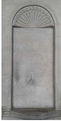
Resim 283: Lambalık Detayı
