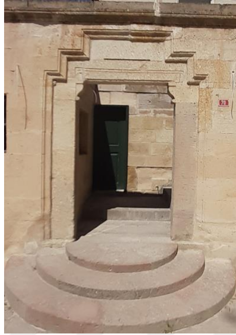
Resim 171: Yapının Avlu Kapısı
