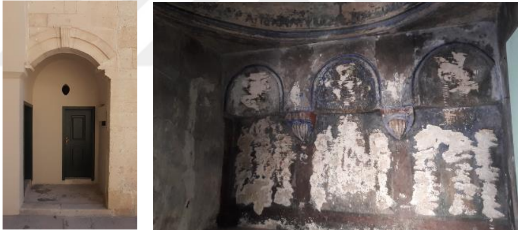
Resim 163: Üst Avluya Açılan Şapel Giriş Kapısı ve İç Mekan
