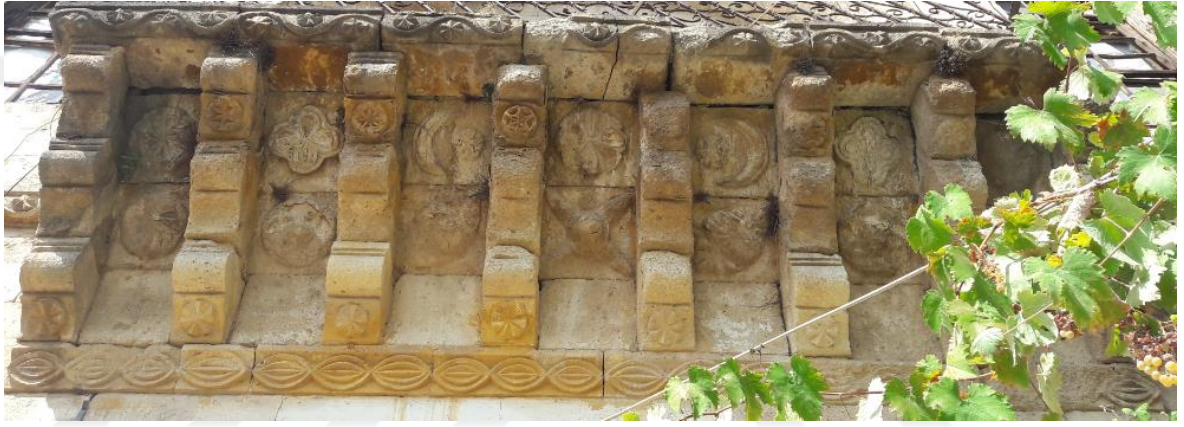
Resim 282: Balkon Altı Konsol Detayı
