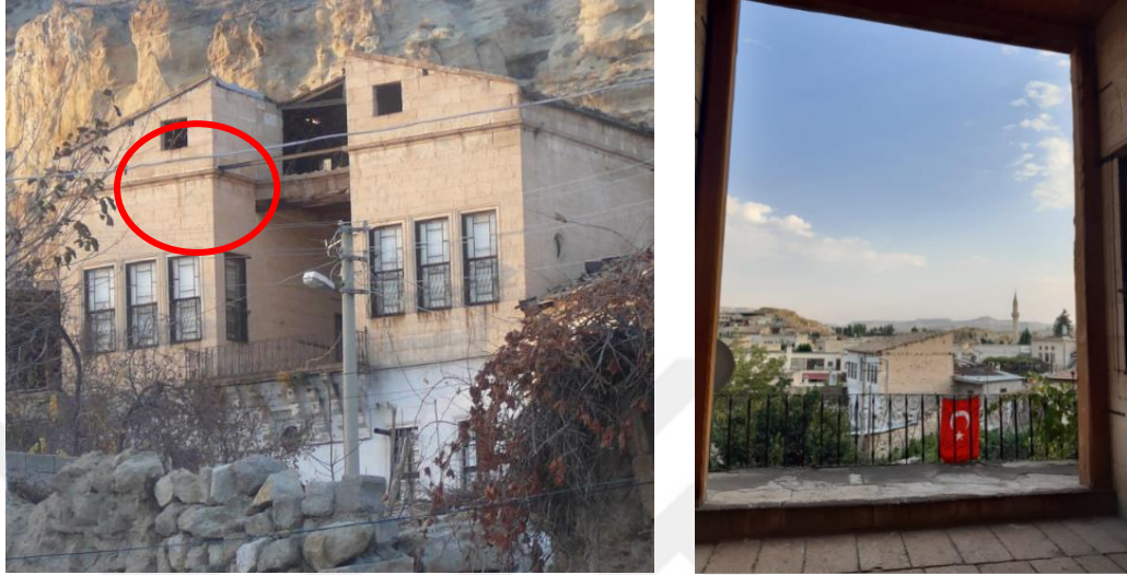
Resim 259: Günümüze Ulaşmayan Balkon Duvar İzleri
