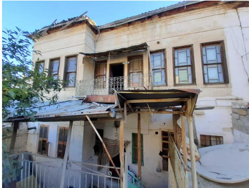
Resim 239: Yapının Ön Cephesi
