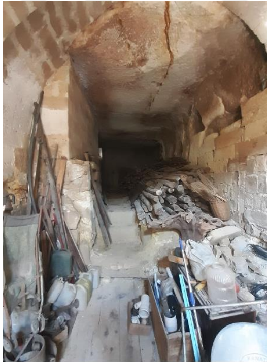
Resim 273: Kaya Oyma+ Yığma Sistemde Yapılmış Ambar
