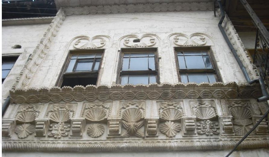
Resim 126: Kat Silmesi Detayı
