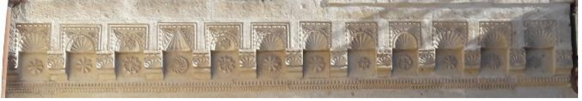
Resim 183: Yapının On İki Nişten Oluşan Kat Silmesi Detayı
