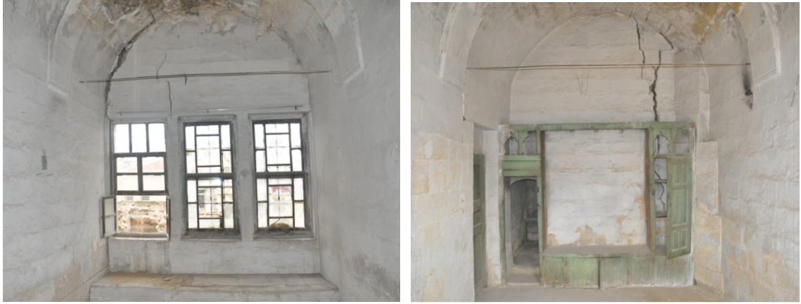
Resim 150: 101 Numaralı Oda Pencere, Sedir ve Dolap Detayı
