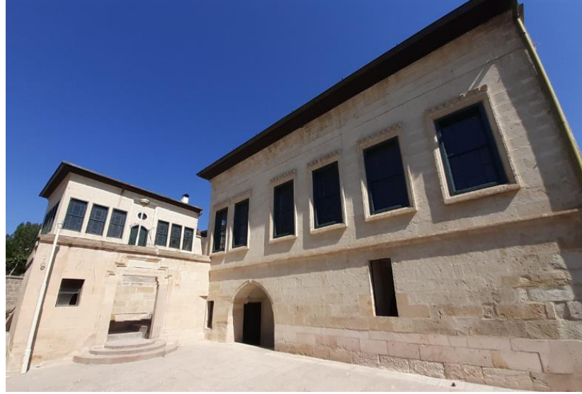
Resim 169: Yapının Ön ve Avlu Cephesi
