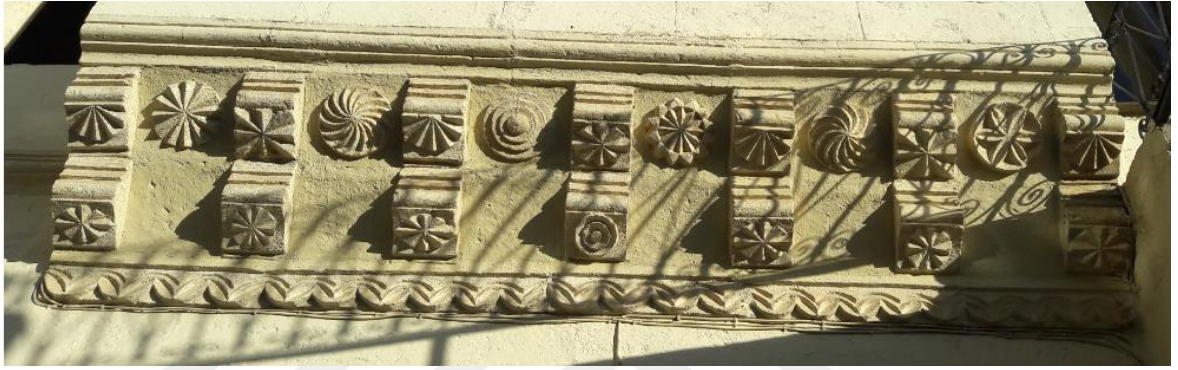
Resim 225: Kapalı Çıkma Altı Konsol Detayı
