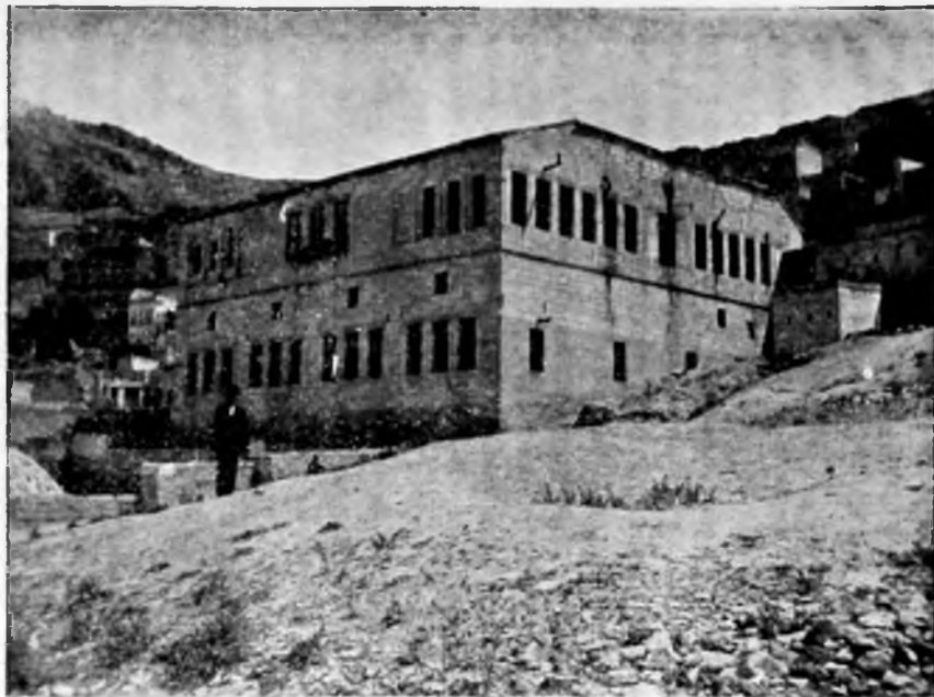
Nevşehirde Astiki Sholi (Şark-u şimaldan görünüşü)
