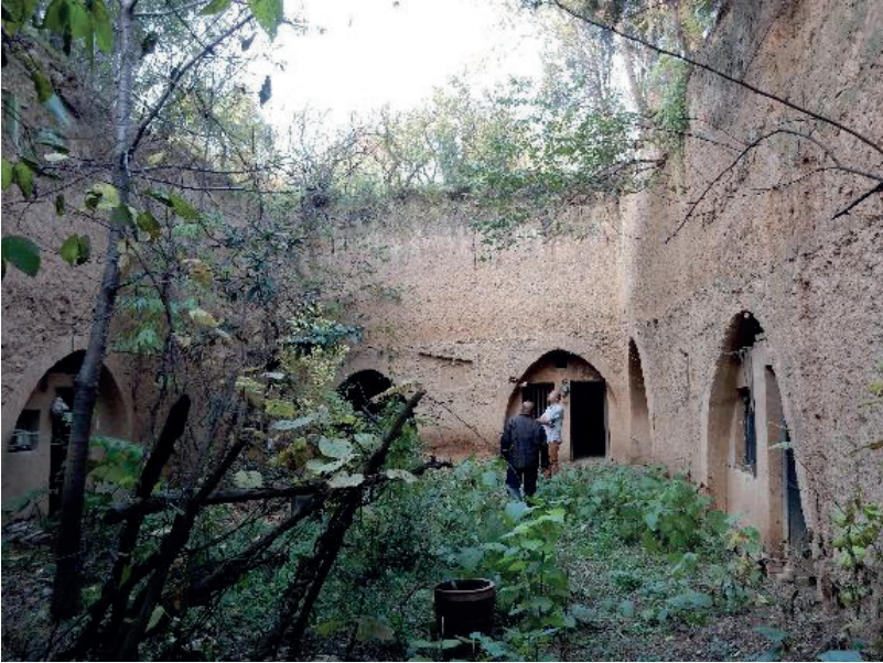
Şekil 3. Yáodòng, içine çökük avlu tipi (sunken courtyard-type) (Frenda, 2015).
